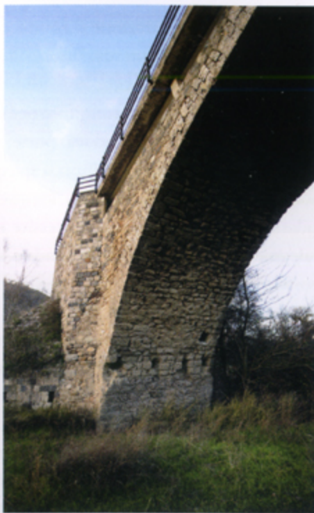
Il ponte di Pietra dell'Ogliaio – spalla (foto Mario Spagnuolo)
