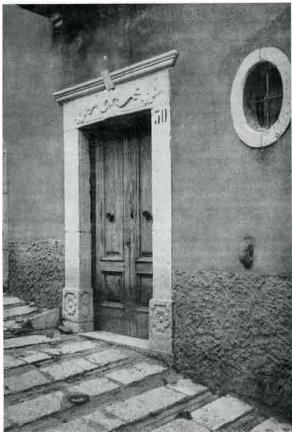
Portale settecentesco di via Chfena.
