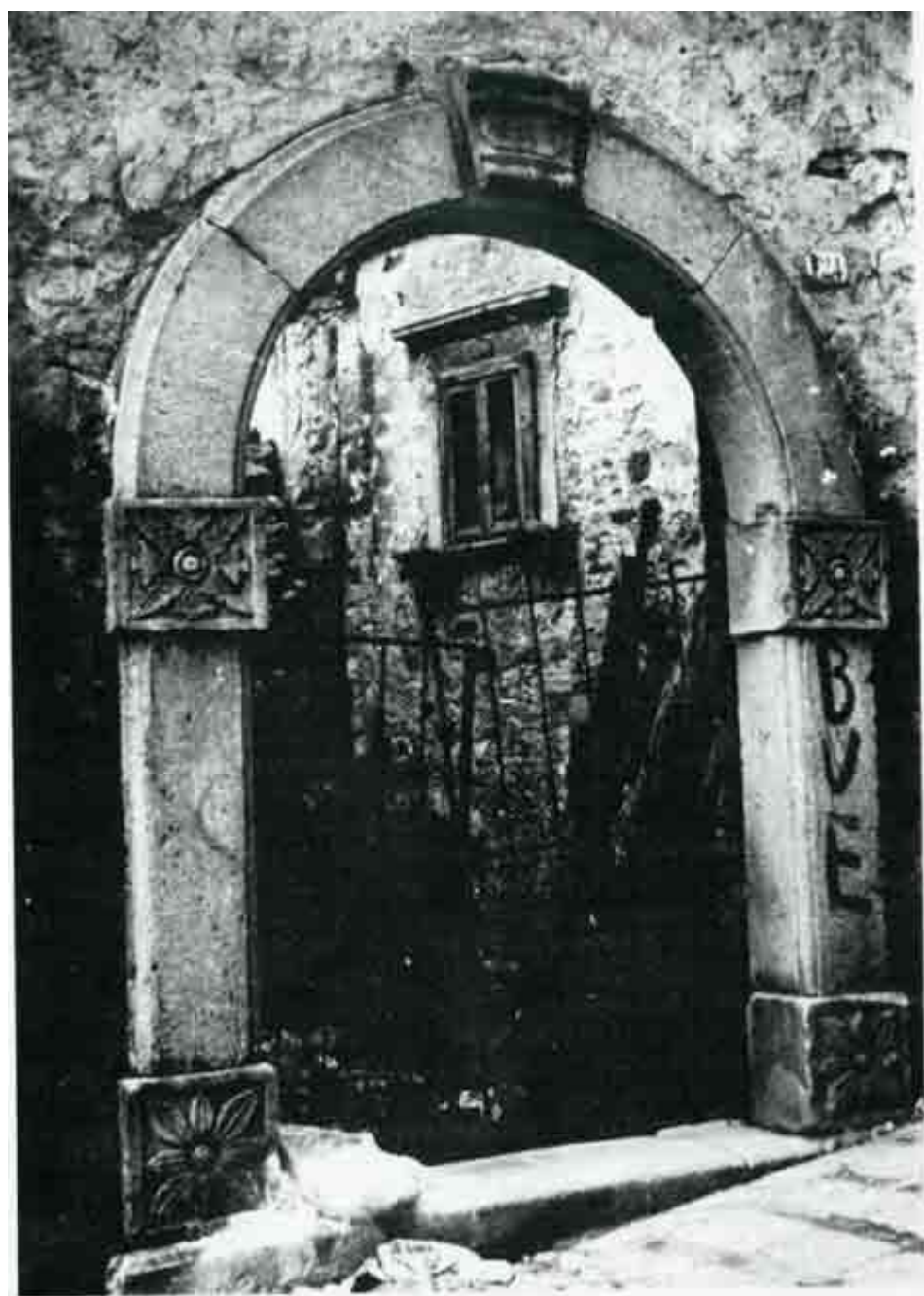
Portale di casa Mariani: notare nel cortile d'accesso il tipico davanzale sagomato a gola rovescia. L'edificio è stato abbattuto dopo l'ultimo terremoto.
