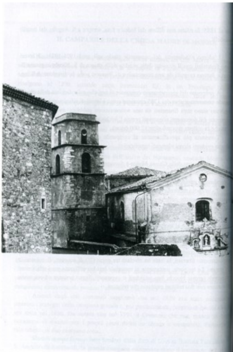
Figura 19 Campanile prima del sisma
