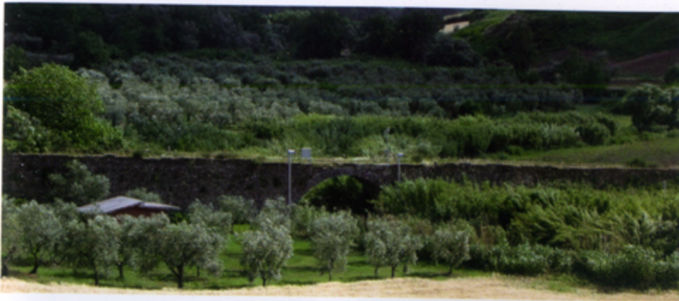
Ponte dell'Arcidiaconata (lungo circa 100 m)
