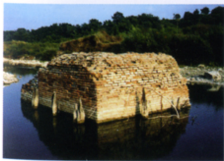
Resti di pilone su torrente Sarda (foto anni Sessanta)
