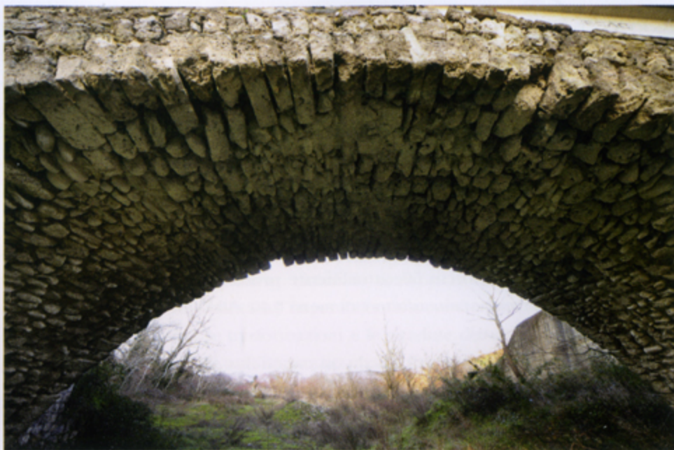
Ponte di pietra dell'Oglio – particolari muratura (foto di Mario Spagnuolo)
