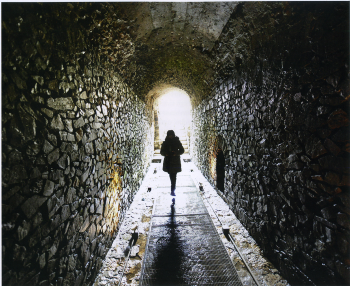
Cisterne romane di Frigento (foto di Mario Spagnuolo)
