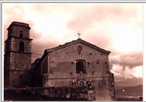
Il campanile e la chiesa prima del terremoto
