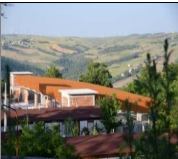
La piscina comunale durante la costruzione
