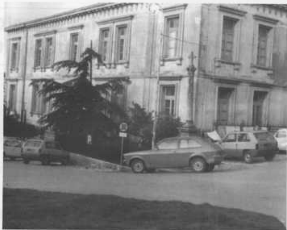
L'edificio delle scuole elementari di Andretta.
